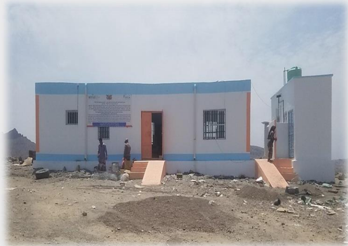
المركز الصحي بعد تدخل الجمعية وإعادة تأهيله
